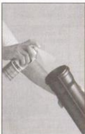
Aplicación de solución lubricante.
